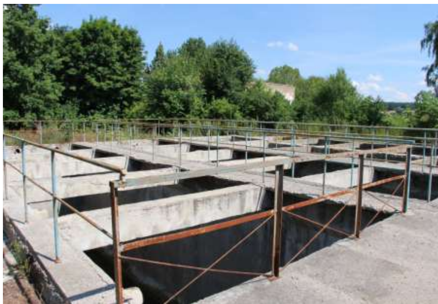
Figura 6. Construcția filtrelor biologice cu aerare prin tuburi din PP nefinalizate
