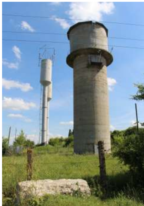
Figura 4. Castel de apă pentru înmagazinarea apei potabile
